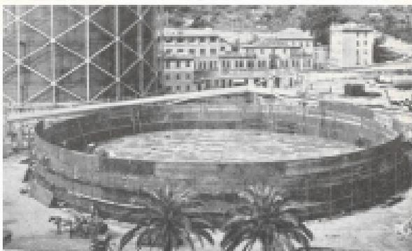
La costruzione di un gasometro a tenuta idraulica da 100.000 mc., ordinata dall'Azienda Municipalizzata Gas e Acqua (A.M.G.A.) di Genova, è già a buon punto, come si vede da questo lato scattato all'Oberina gas della Garitta.
